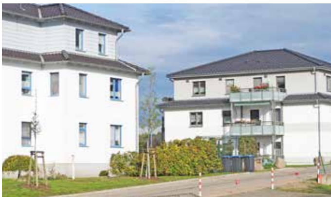
Eigentlich plant die UWG weitere solcher Stadt villen in Ueckermünde. Doch aktuell sind die Baukosten einfach zu hoch und würden zu enorm hohen Mietkosten führen.
